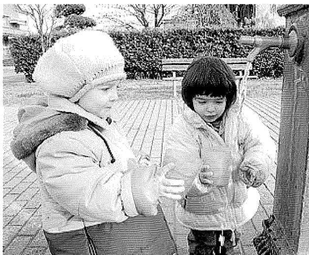
CANTIERI Cap Holding ha dato il via alla sostituzione della rete idrica nelle vie Volturno e Origoni (Np)
