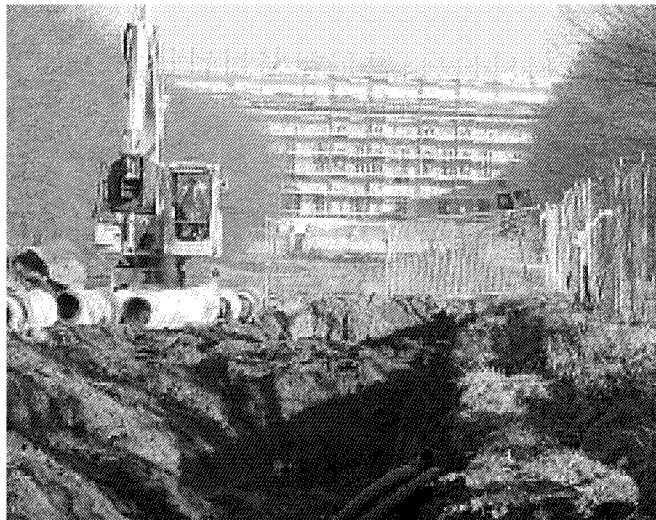
Il cantiere di Cap holding è stato aperto martedì 13 dicembre
